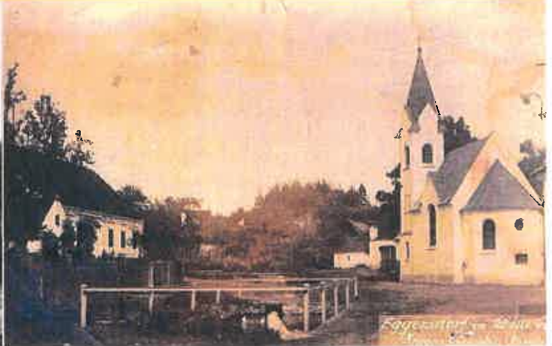
➤ Die neue errichtete Kapelle 1926.
