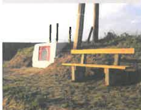
Das Fundament der ersten Trafostation
