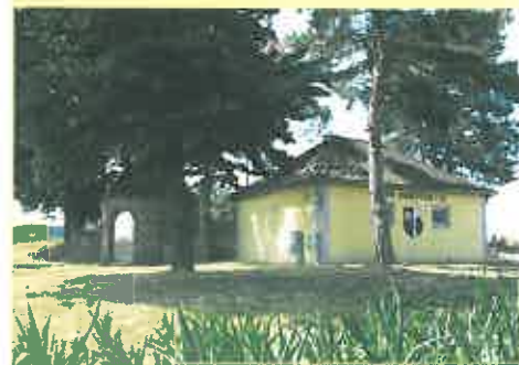
der Hochbehälter der WVA Karlstein
